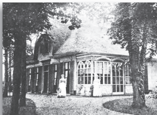
afb. 43 - Villa Heidezigt Brinklaan 134, bewoond door de fam. Luijckx. foto uit 1900.
