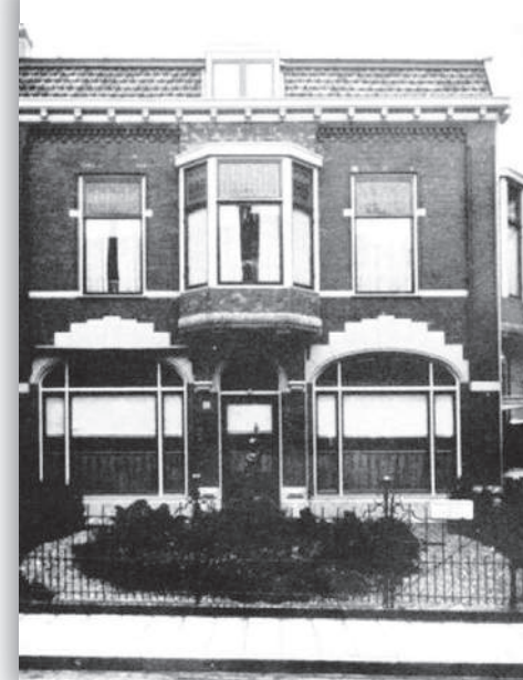
Kantoor van de waterleiding in de Nassaulaan, 1960
