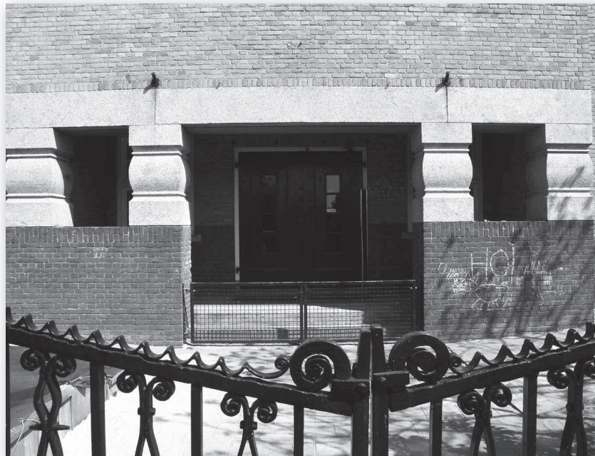
Ingangspartij aan de westkant. (foto auteur)
