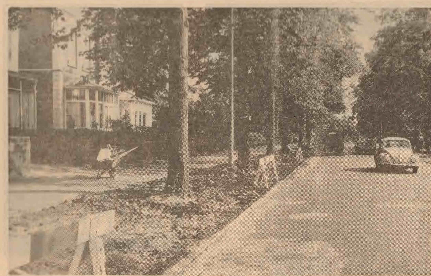
Werk in uitvoering aan de Brinklaan tussen Vituskerk en Prinsenstraat. Meer ruimte voor parkerende automobilisten plus een fietspad achter de bomen, die met veel zorg worden behandeld.
