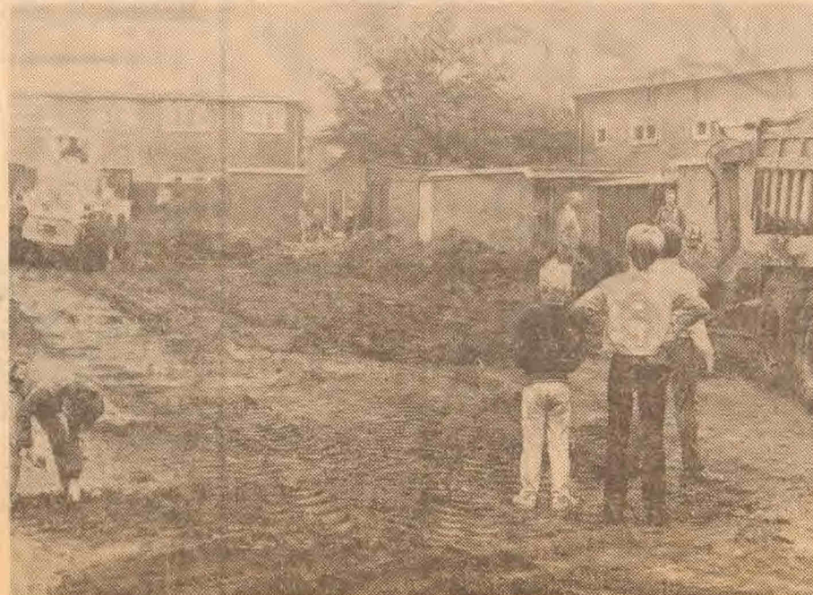
Met groot materiaal, beschikbaar gesteld door de firma Boomgaard, is zaterdag begonnen aan het grondwerk voor het
