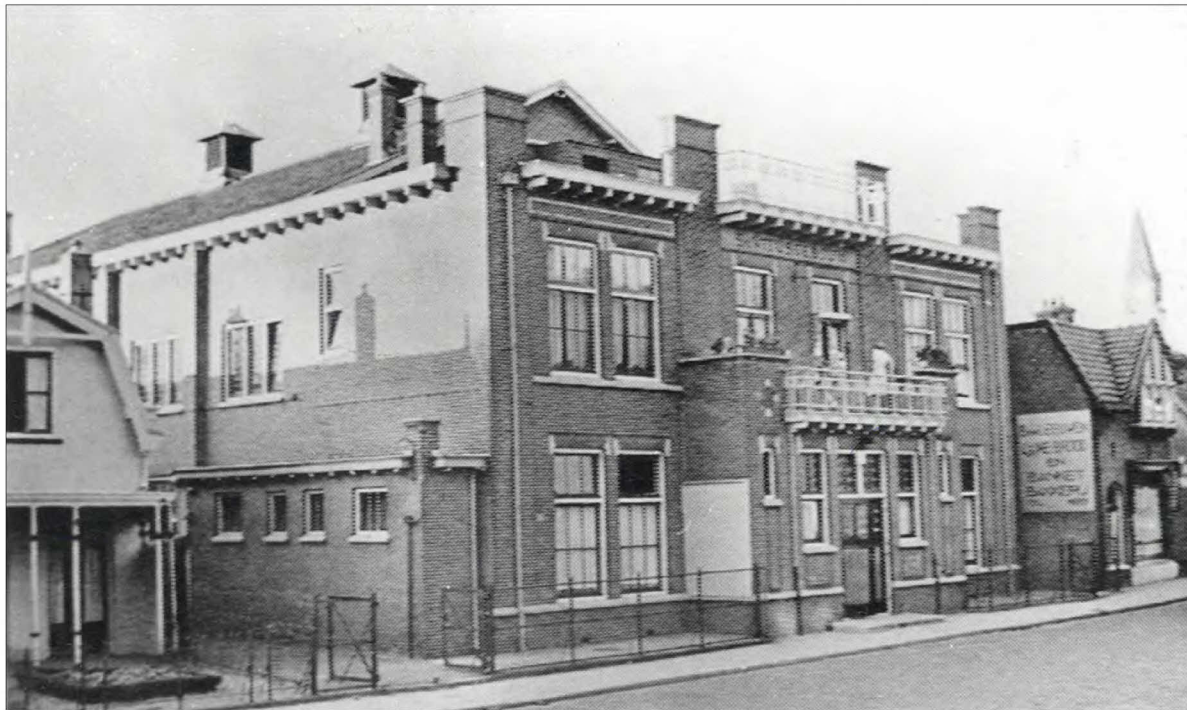
Het St. Vitusgebouw in de St. Vitusstraat als r.k. verenigingsgebouw. In 1971 als televisiestudio afgebrand en gesloopt (fotocoll. HKB)
