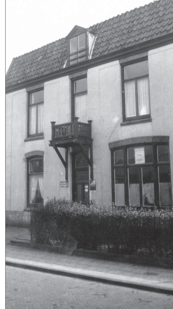
Het huis van het gezin Snieder, Iepenlaan 7, voor de verbouwing
