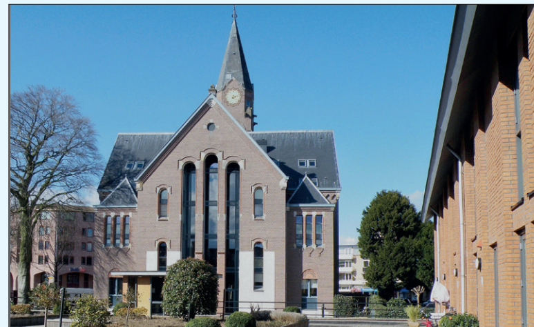
De achterzijde van de verbouwde Vredekerk (foto Jaap van Hassel)
