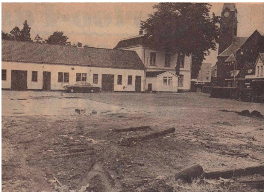
De zojuist ontruimde werf van het GEB aan de Nieuwstraat in 1972. Op de achtergrond villa Schoonoord, die het jaar daarna zou worden afgebroken
