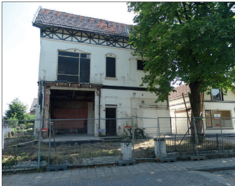
Het pand in 2012 tijdens de renovatie.
