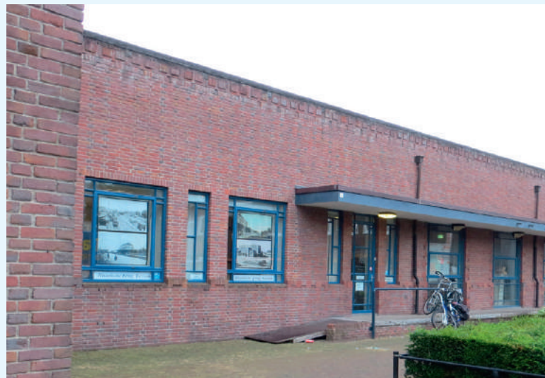
De HKB in de lage rechtervleugel van station.
