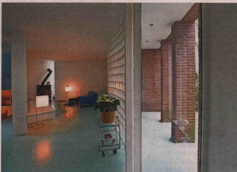
De gewelfde glaswand is meteen ook de buitenmuur.
