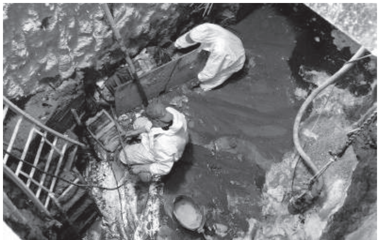
Liftschacht station Naarden-Bussum, waterdoorbraak uit wand, 30 mei 2012 (foto Jaap van Hassel)
