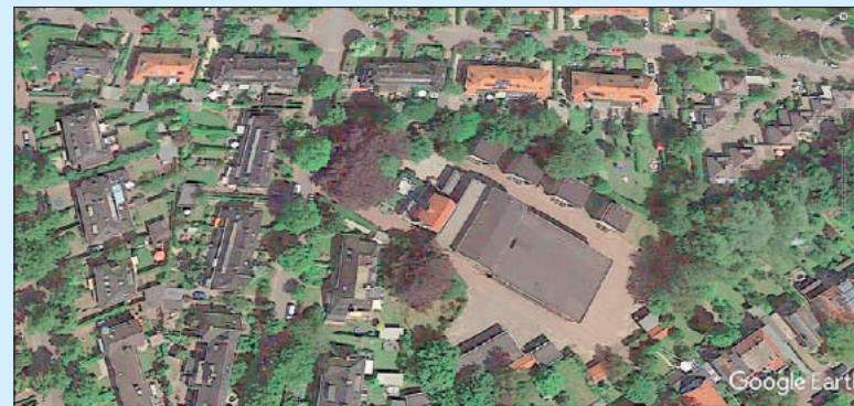
Het complex nu aan de Prins Willem van Oranjelaan in Naarden. De woning (rood dak) valt in het niet bij de huidige bedrijfsgebouwen.
