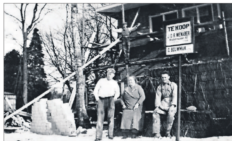
Prinses Irenelaan 9 in aanbouw in 1935.
