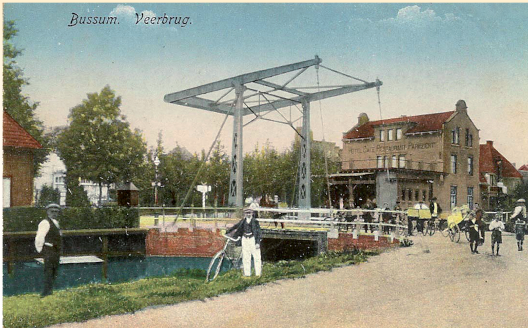
Gezien vanaf de Landstraat; de brug is niet de Veerbrug, die lag wat dichterbij het dorp.
