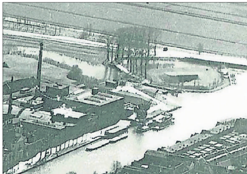
■ Het voormalige Fort H.
