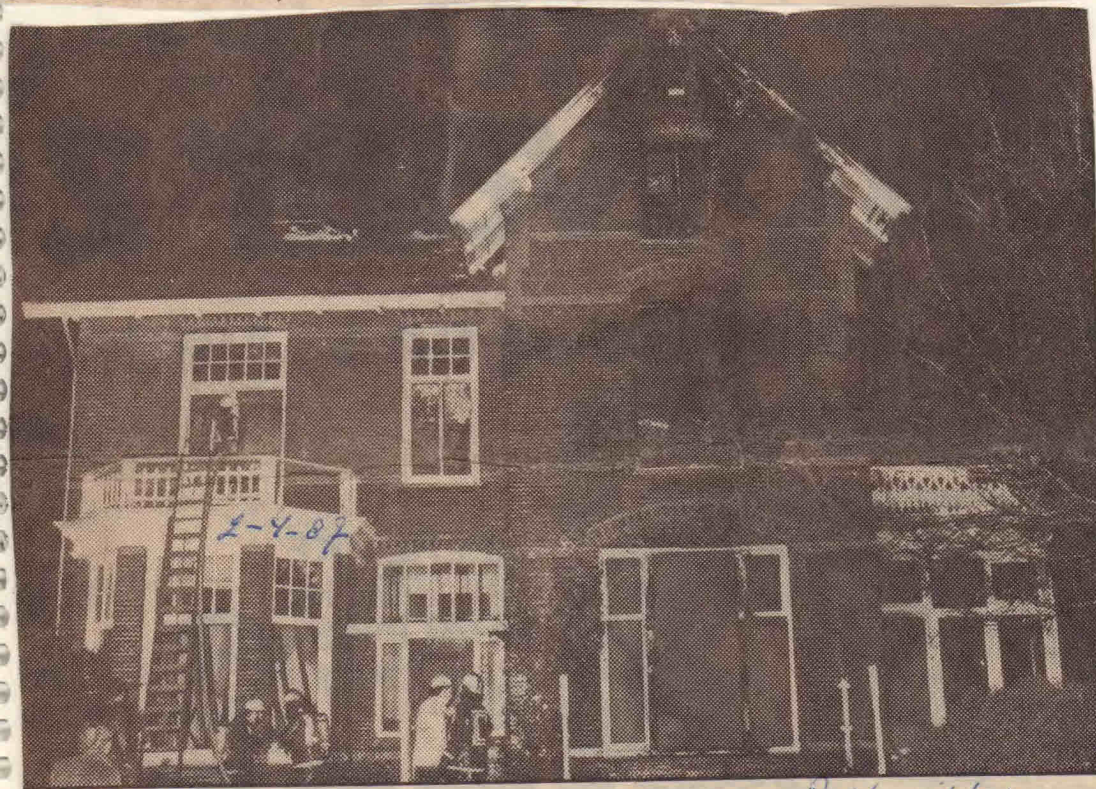
● Na de brand stonden alleen de buitenmuren van de leegstaande villa er nog. Prins Hendriklaan
