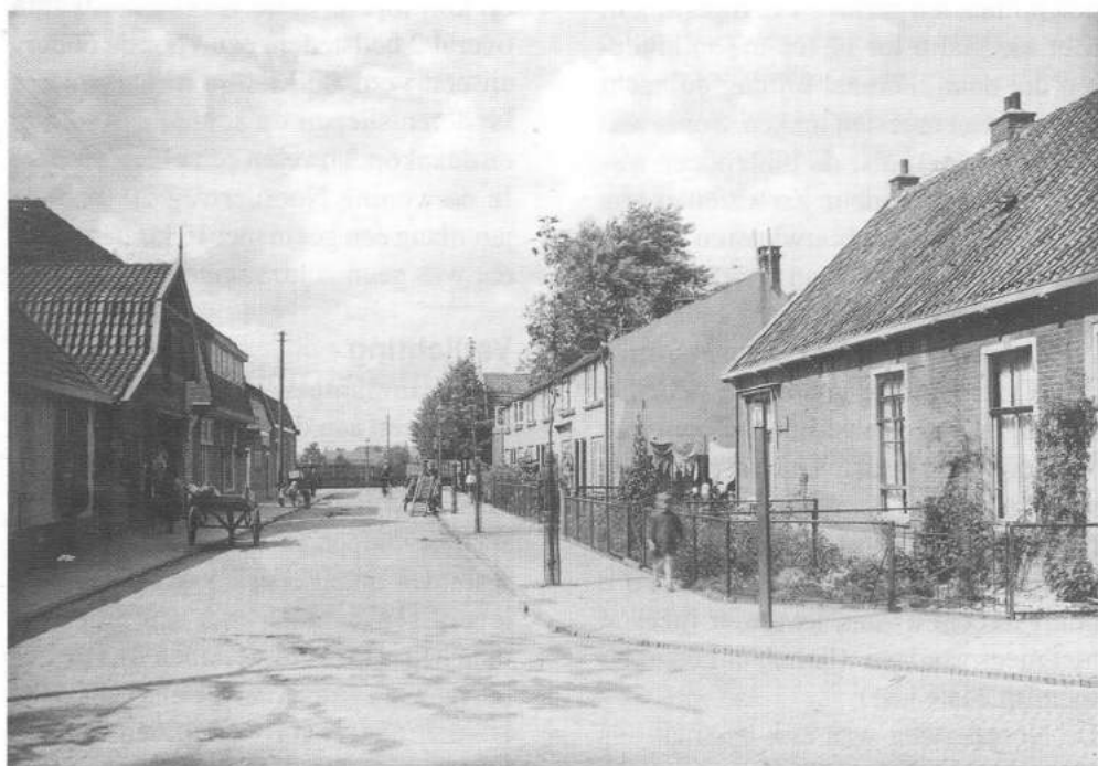
Foto (1931): de Noorderweg gezien in de richting Driestweg.
