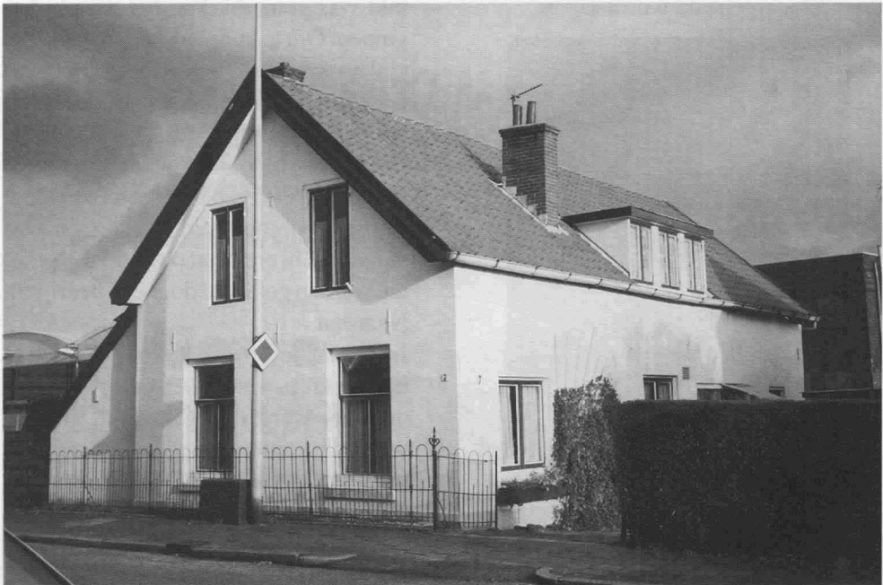
Foto (1990): de woning Brinklaan 7, die in 1991 is afgebroken
