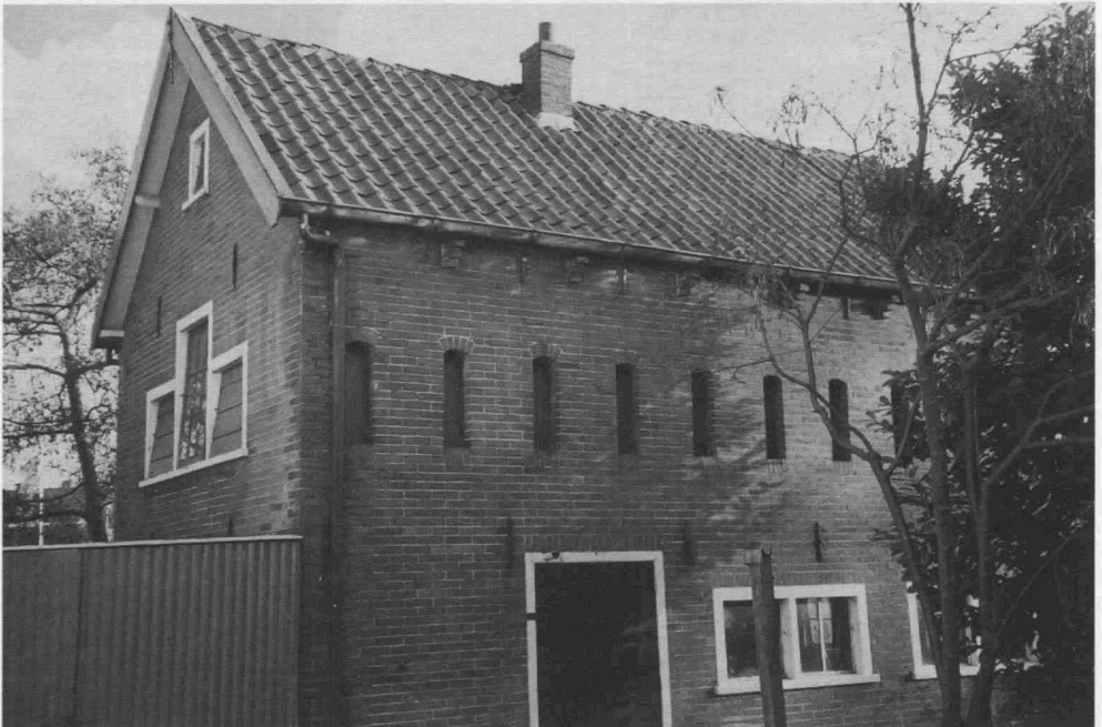
Foto (december 1990): de droogschuur met ventilatie-openingen, die rechts van de woning Brinklaan 7 stond
