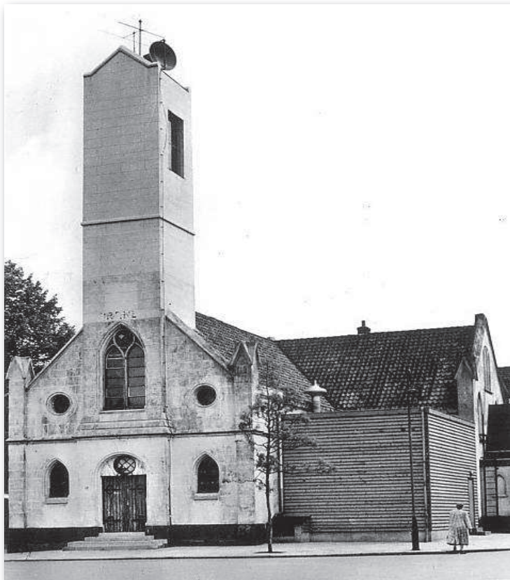
De hoek is ingevuld met een houten uitbouw
