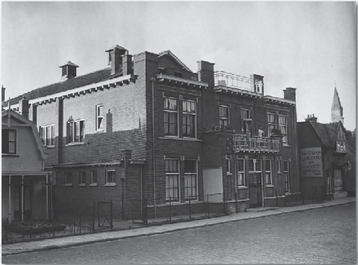
Het Vlieggebouw voor de verbouwing
