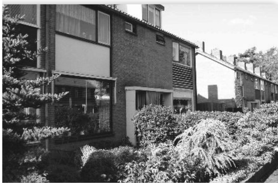
Laarderweg. Bij de entreepartij is beton toegepast. Een uitspringend detail in een repeterend beeld
