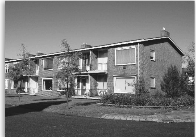
Bloemhof: ruim in het groen, eenvoudige repeterende bouwstijl, bitumineuze dakbedekking is goedkoper dan pannen.
