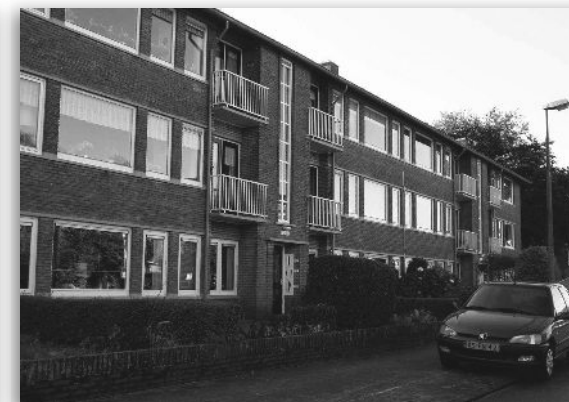
Ceintuurbaan Portieflats. Flatgebouw met drie woonlagen met een repeterend karakter. De verbijzondering is te vinden in het metselwerk en de raampartijen van de trappenhuisen. Bij bijna alle ontwerpen in het gebied wordt de soberheid van de architectuur even doorbroken door een verfraaiing in de entreepartij.
