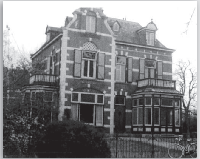
U Villa Beaulieu aan de GraafWichmanlaan
