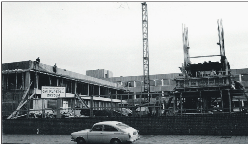
De Bestuursvleugel en carillontoren in aanbouw
