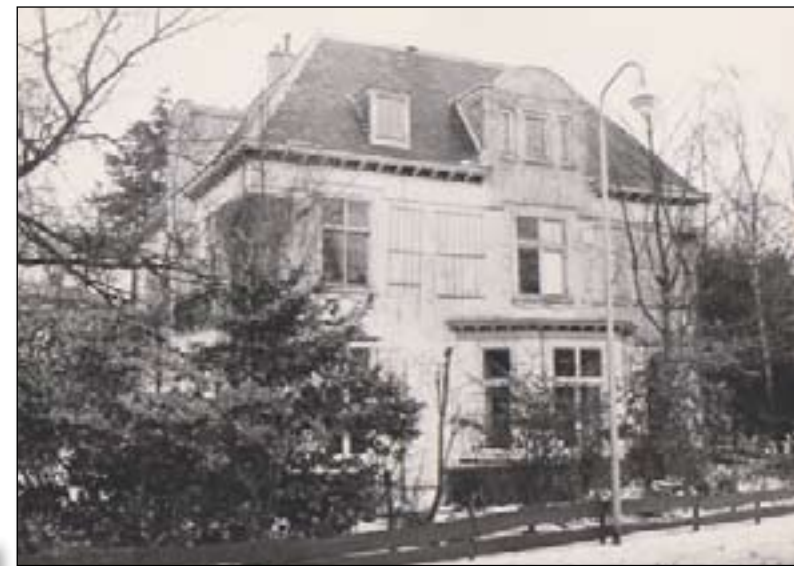
De villa in januari 1980 vóór de restauratie
