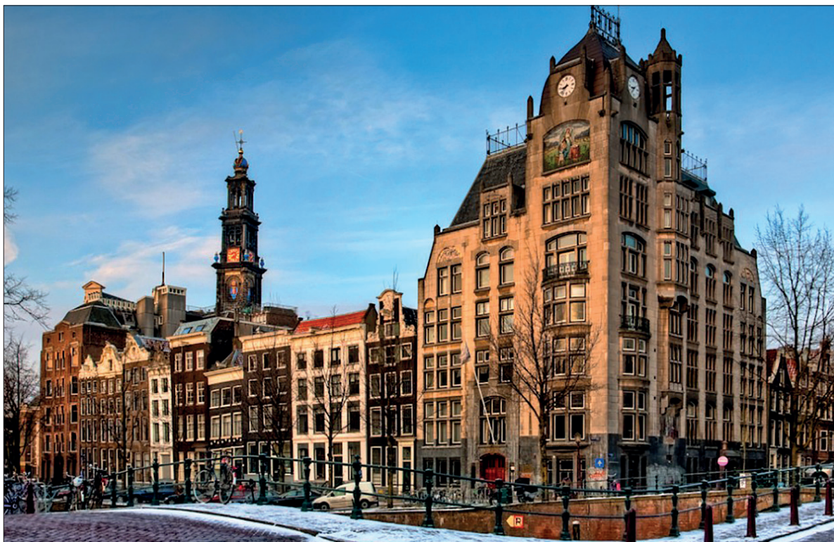
Eerste Hollandsche Levensverzekeringbank, hoek Keizersgracht/Leliegracht
