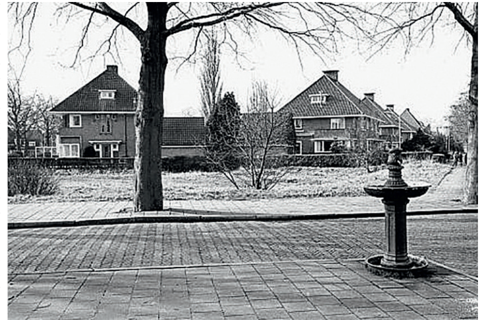
De huizen van de s'Jacoblaan in 1964, gezien vanaf de rijksweg; links de Huizerweg.
