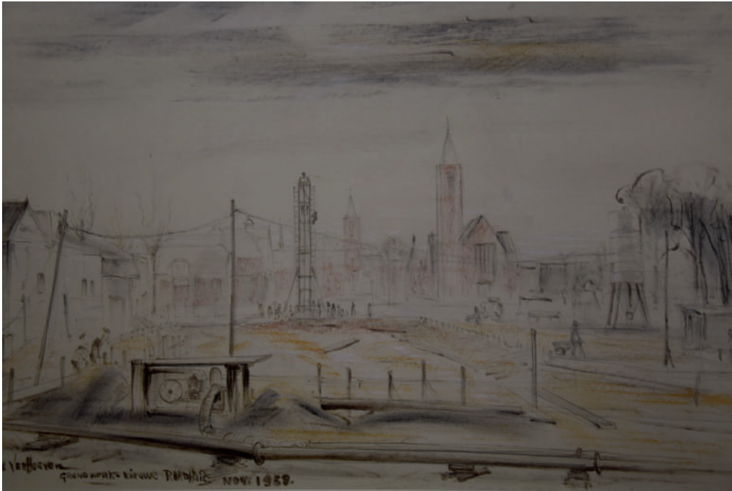
De bouwplaats van het nieuwe Gemeentehuis; rechts de Wilhelminakerk, in het midden de toren van de St. Vituskerk
