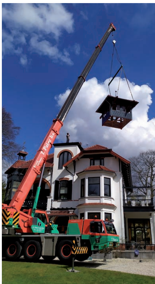
13 april 2021: de toren wordt geplaatst (foto: Eric Bor)
