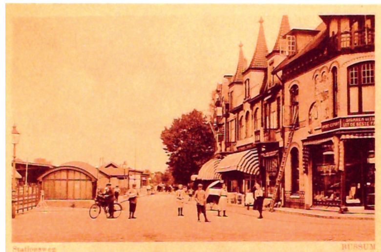
Stationsweg met links de tunnel in/uitgang in 1920.
